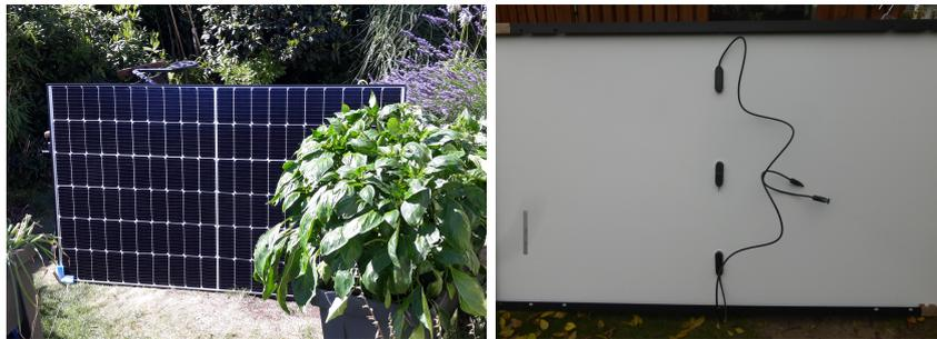
Im ersten Bild sehen wir eines der beiden Solarmoduln vor eine Werkbank gestellt mit Ausrichtung nach Süd-Ost. Auf dem zweiten Bild wird uns die Rückseite geboten. Von der Mitte kommend führen die beiden Kabel, Plus- und Minuspol, zum Wechselrichter.
