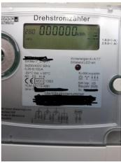
Dieser digitale Zähler kennt verschiedene Modi: zum einen 180, die Anzeige des Verbrauchs, zum weiteren 280, die Menge des eingespeisten Strom in Kilowattstunden. Das ist ein brauchbarer Zähler für uns.
