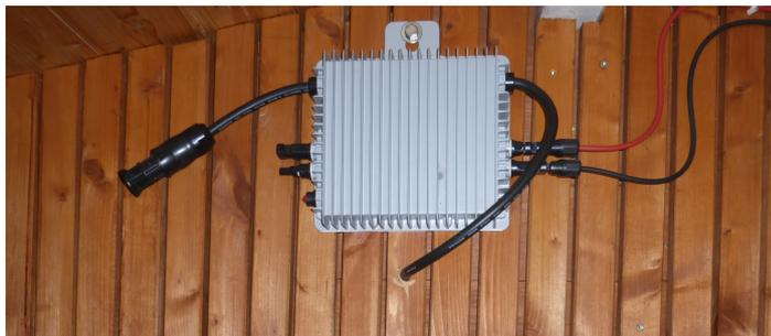
Der Wechselrichter ist Aussen angebracht, weil er da gekühlt wird.
